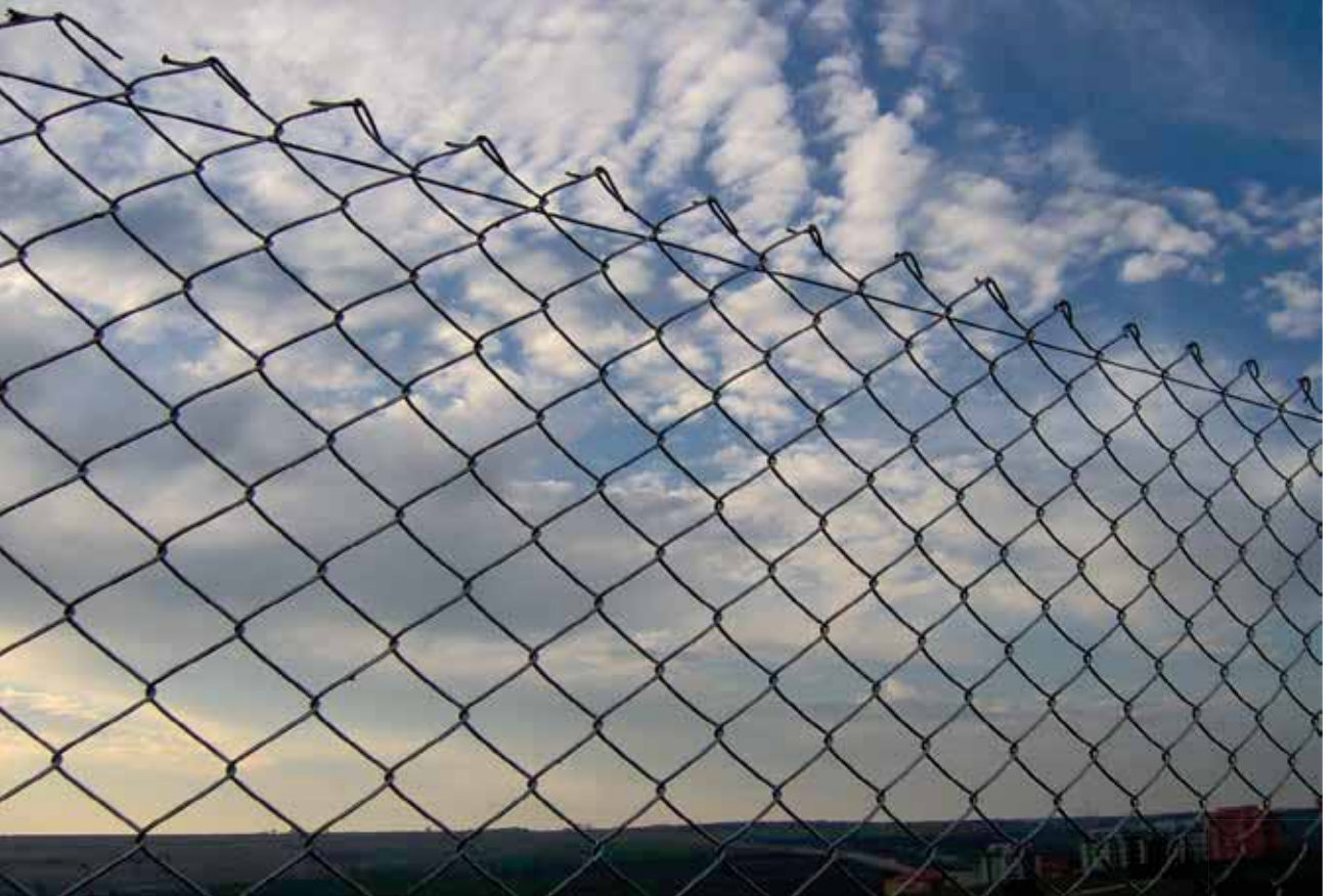
Galvaniz tel örgü uygulaması Galvanized wire mesh application
